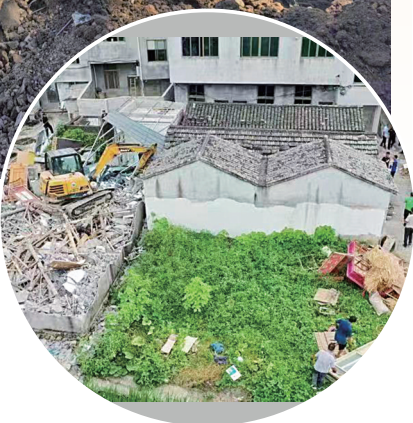
鸡鸭棚拆除现场。
